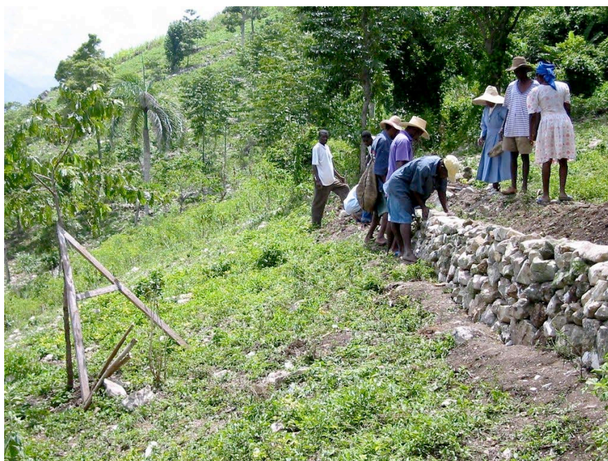
Bau einer Erosionsschutzhecke
